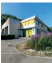
S 123 EPTINGEN BLT DEPOT UND GARAGE
