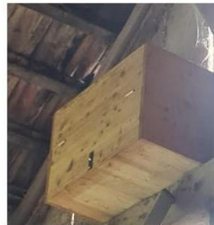
Der Nistkasten wird positioniert und das Einflugloch eingezeichnet. Das Einflugloch wird mit der Stichsäge in der Wand ausgeschnitten und der Nistkasten befestigt.
