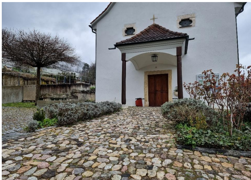
Die historische Pflästerung vor der Kirche als Stolperfalle.
