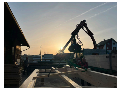
Der Kran hebt das neue Dach an
