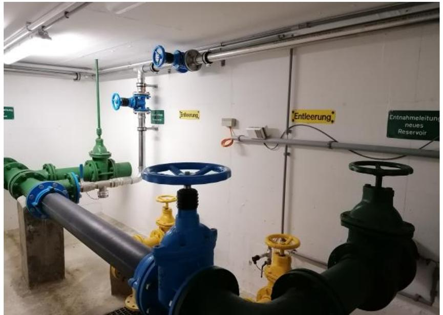
Im Idealfall läuft das Wasser von der Quelle in die Wasserkammern des Reservoirs. Sind die Kammern voll, läuft das Wasser durch den Überlauf in den Bach. Schüttet die Quelle nicht genügend Wasser, wird die Grundwasserpumpe in der Klus eingeschaltet.
