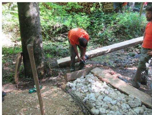
Instandsetzung Fussweg mit Trittschwellen und Hangsicherung Oberer Teil des Weges
