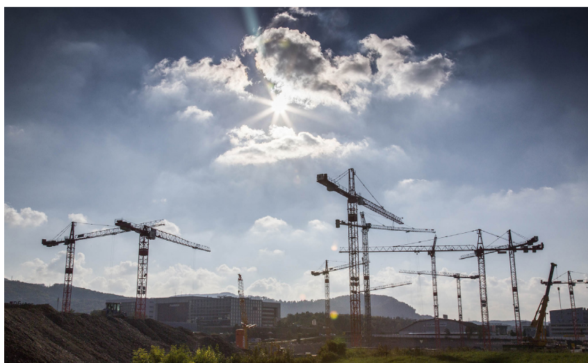
Baustelle Coop, Lobos Oktober 2014
