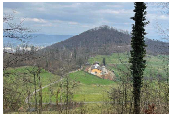
Nach/während dem Bau (März 2025) und ohne Umgebungsgestaltung
