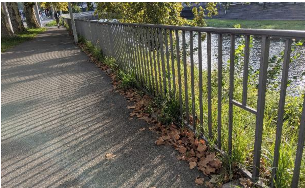
Abb. 21: Ein Durchgang in einem Metallzaun, der bereits bei der Erstellung des Zauns eingeplant war und sich rund alle 20 Meter wiederholt (© Sandra Gloor / stadtwildtiere.ch).
