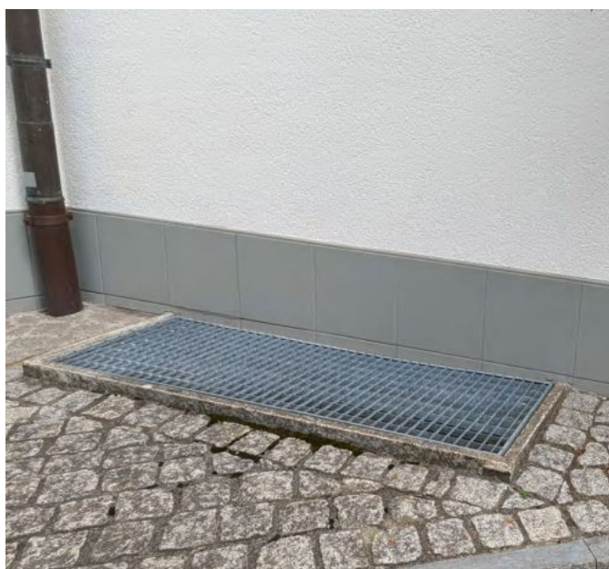
Vergittertes Oberlicht © wildenachbarn.ch
