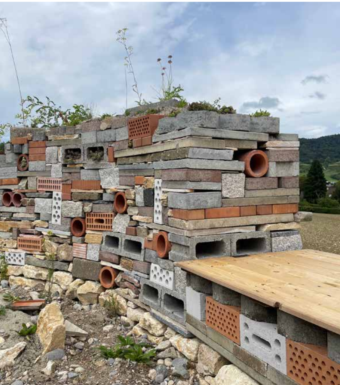
Beispiel einer Trockenmauer aus Recyclingmaterial mit integrierter Sitzmöglichkeit, Ebenrain
