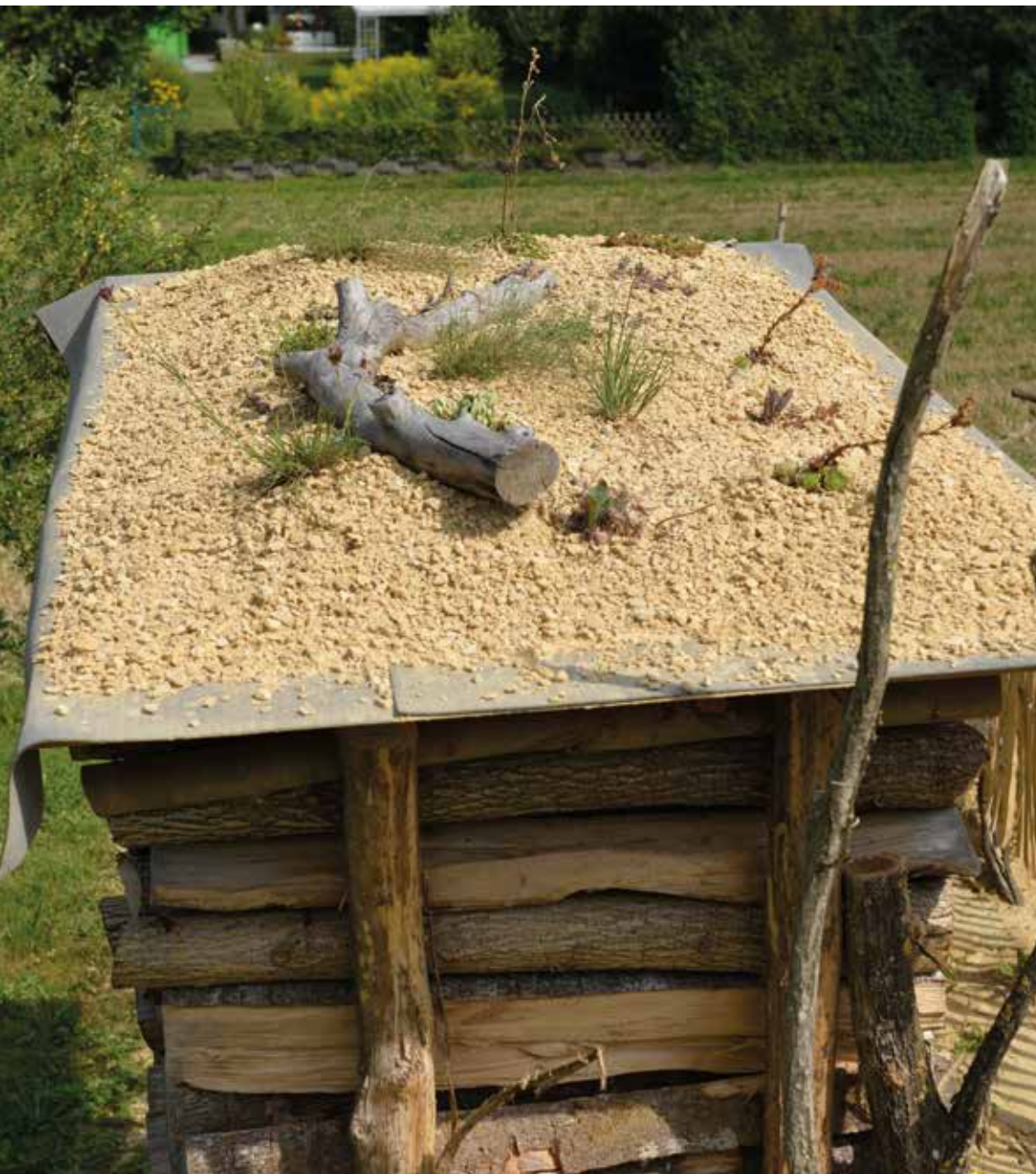
Beispiel einer frisch angelegten Dachbegrünung im Strukturengarten Ebenrain, Sissach
