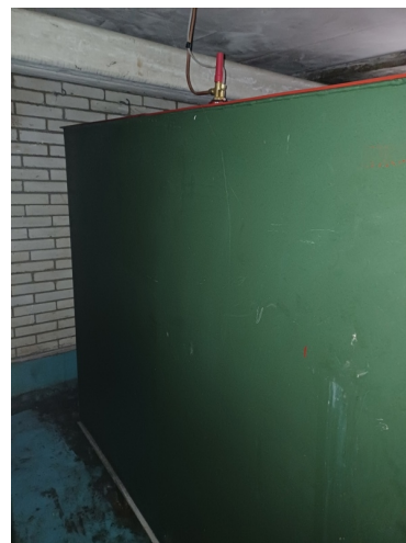
Revidierter Stahltank 6800 l (12/2025)
