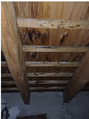
Dachuntersicht von Estrich
