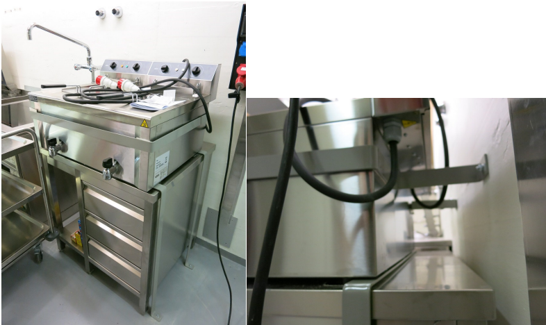
Fritteuse, die schocksicher befestigt ist
