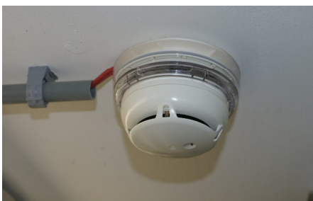
Brandmelder in Schutzbaute
