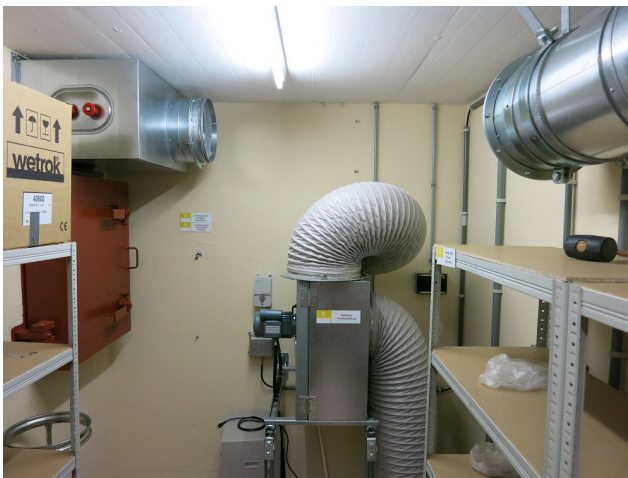
Ortsveränderlicher Abluftventilator integriert in den Schutzzumfang mit Überdruckventilen (UeV) in der Ablufthaube und Explosionsschutzventilen (ESV) im Abluftkasten gegen aussen
