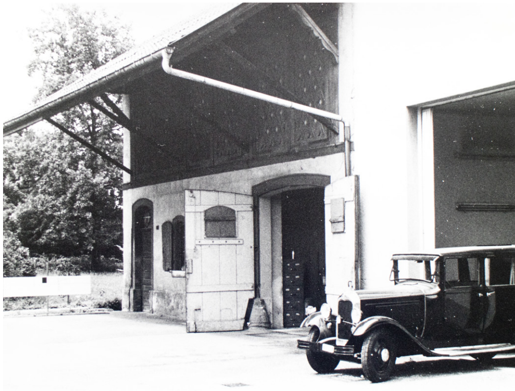
Fahrzeugprüfungen Füllinsdorf (Ende 60er, anfangs 70er-Jahre)
