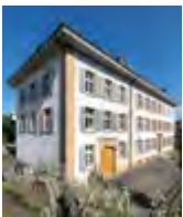
S91 ALLSCHWIL, GEMEINDE- SCHULHAUS
