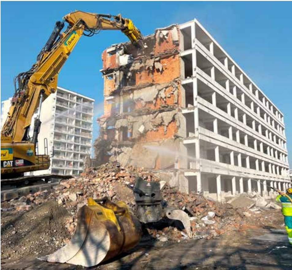
Baustelle in Pratteln
