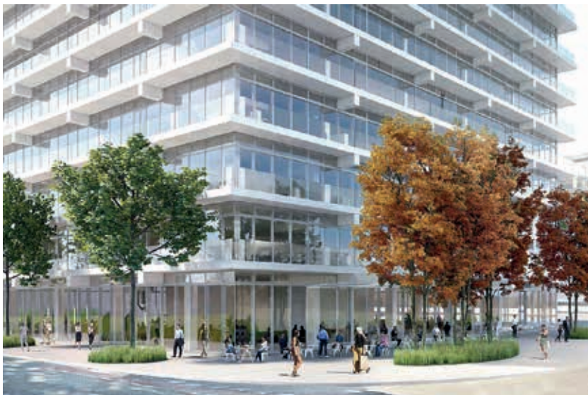
Das ALBA Geschäftshaus auf dem BaseLink Areal in Allschwil bietet grossen Unternehmen, KMU und Gewerbe, aber auch Start-ups beste Voraussetzungen bei ihren Geschäftstätigkeiten mit Bezug zu Diversität, Kreislaufwirtschaft, Innovation und Nachhaltigkeit.
