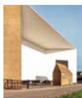
S 113 MÜNCHENSTEIN SCHAULAGER HERZOG & DE MEURON
