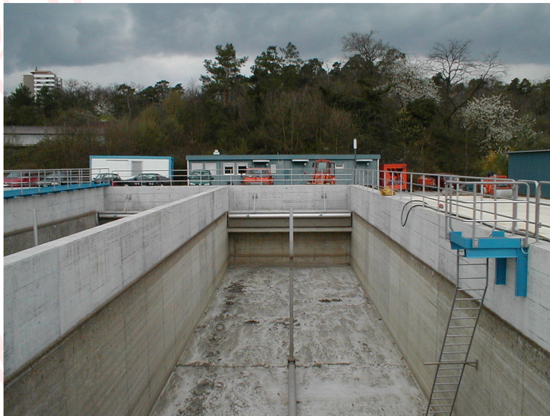
Mischwasserbecken, ARA Birs 1, Reinach
