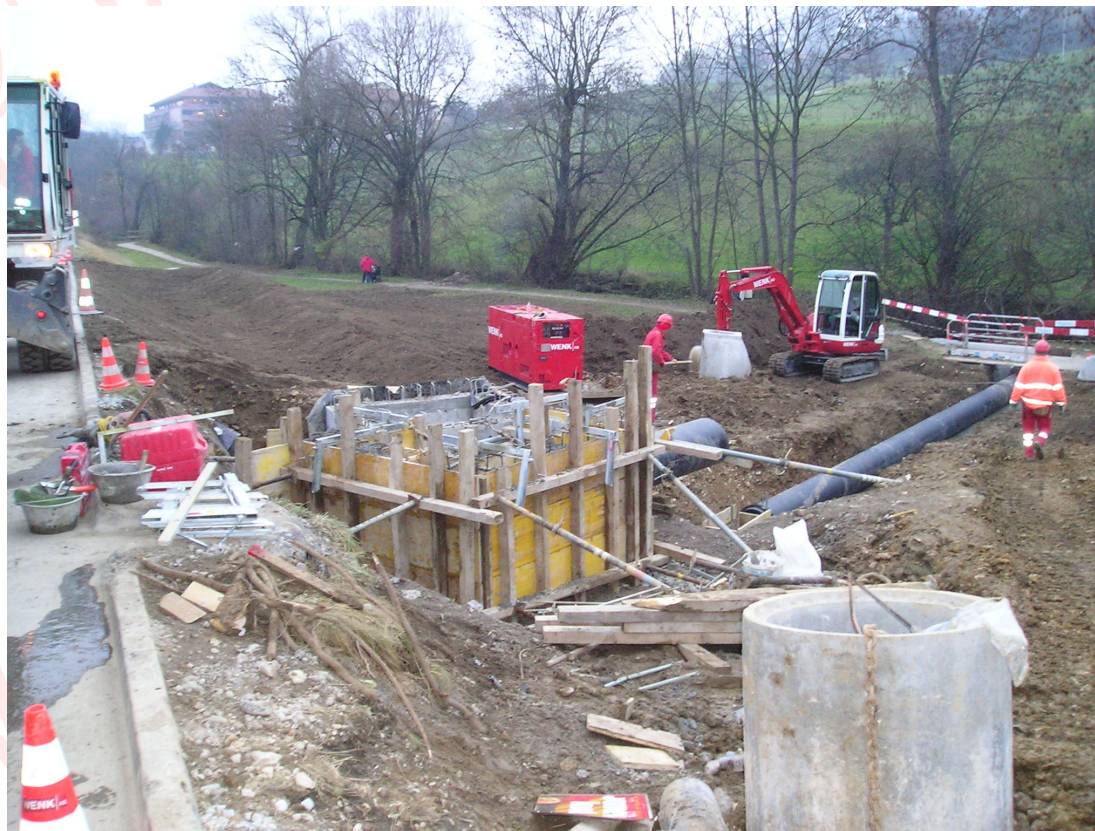
SABA Kantonsstrasse Oberdorf im Bau
