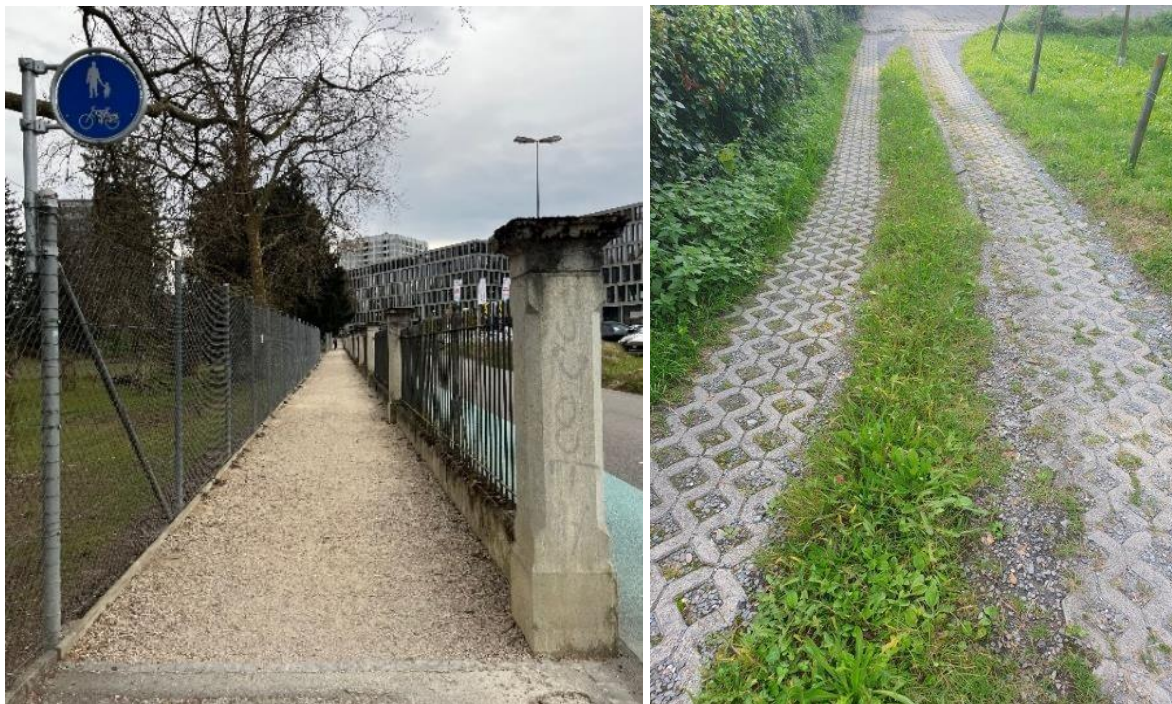
Abb. 19: Chaussierter Geh- und Veloweg (links) und Zufahrtsstrasse mit Rasengittersteinen (rechts)
