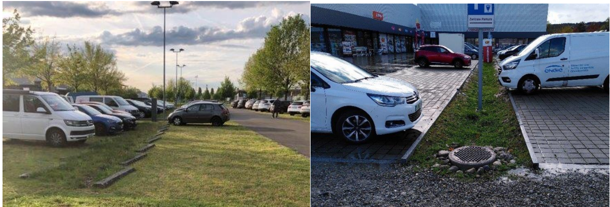
Abb. 18: Versickerungsgraben und Platzretention (links) und Parkplatzgestaltung (rechts & unten)
