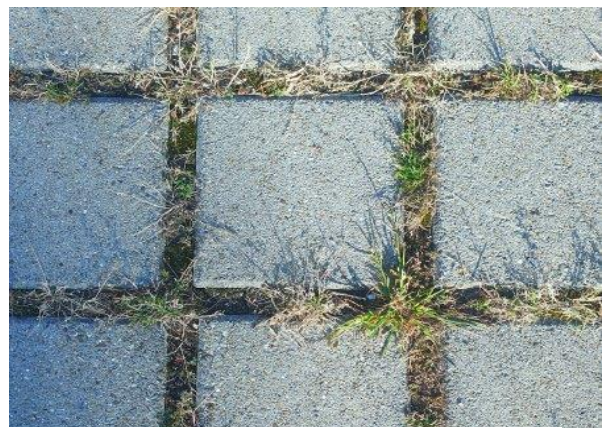
Abb. 3 Sickerverbundsteine mit breiten Fugen
