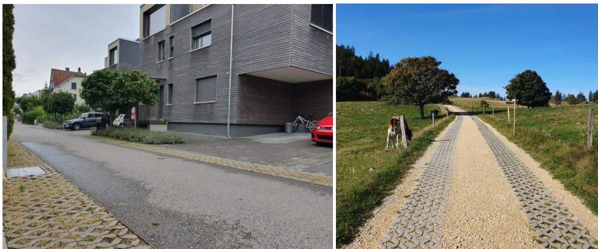
Abb. 20 Quartierstrasse mit Randstreifen aus Rasengittersteinen (links) Nebenstrasse chaussiert mit Rasengittersteinen (rechts)
