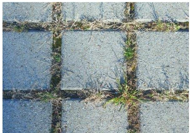
Abb. 3 Sickerverbundsteine mit breiten Fugen
