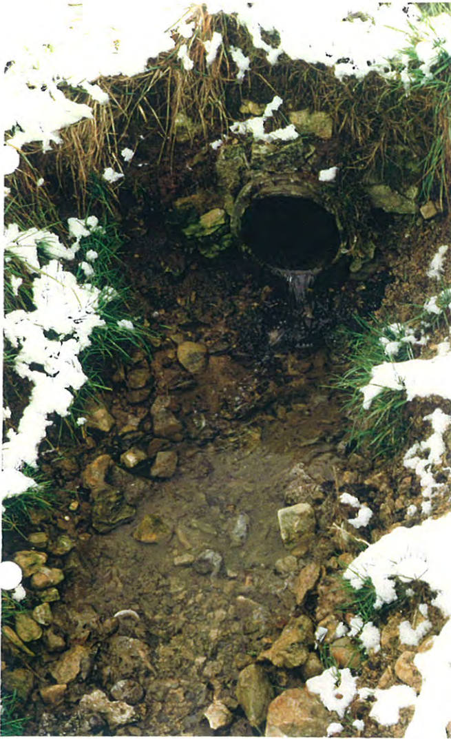
Das Zünbächli wird im Unterlauf durch den Fehlanchluss eines Hauses verschmutzt. Deutlich sichtbar: WC-Papierrückstände im Gewässer.
