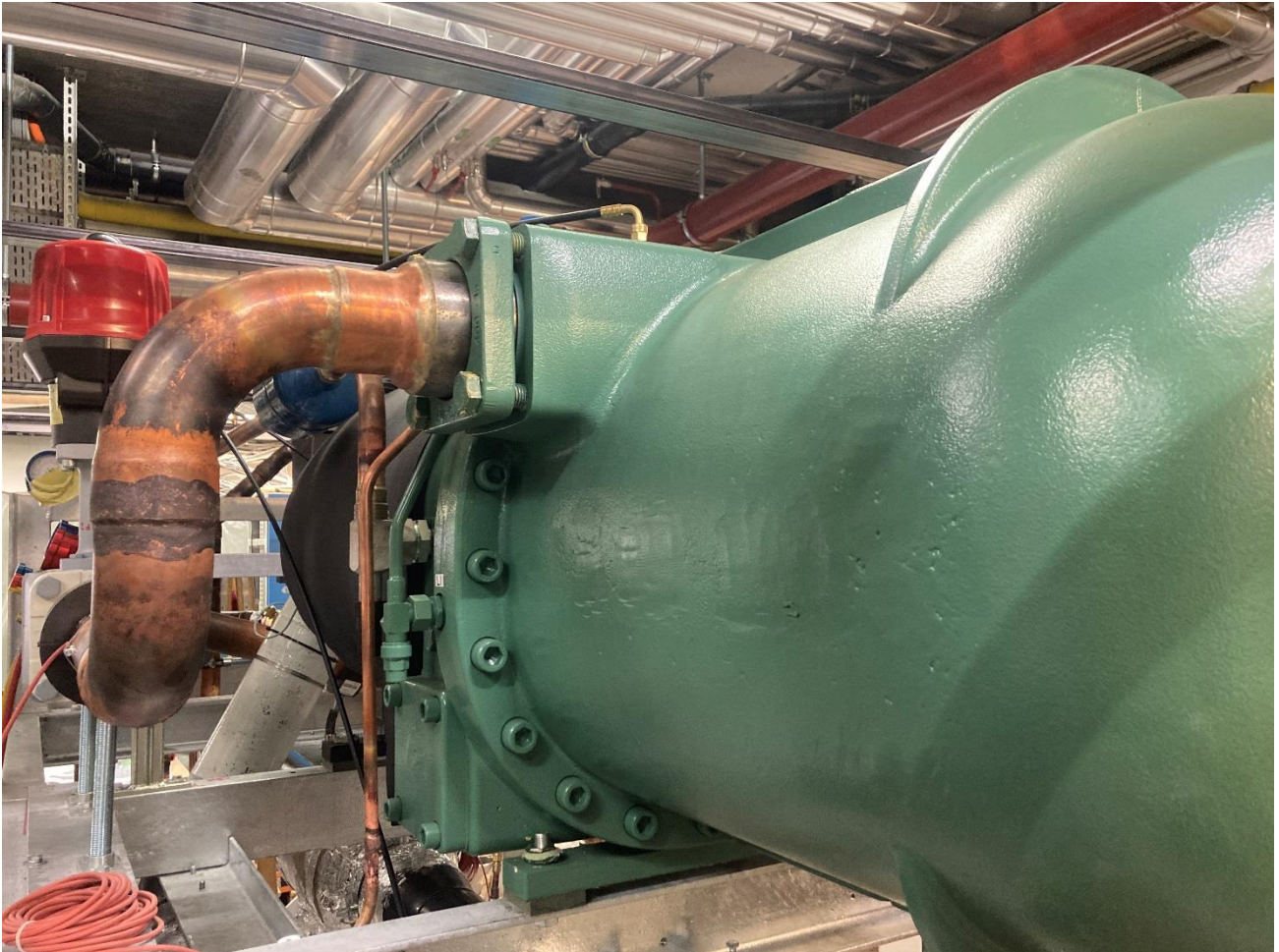
Einbau der Wärmepumpe im Schulhaus Burggarten, Bottmingen.
