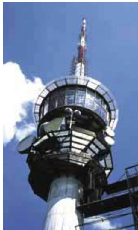
Die Rundfunksendeanlagen Rigi SZ (links) und Bantiger BE (oben). Die Richtfunkschüsseln im unteren Teil der Türme verbinden die Anlagen mit anderen Sendestationen. Oben sind die Antennen für die Verbreitung der Fernseh- und Radioprogramme angebracht.
