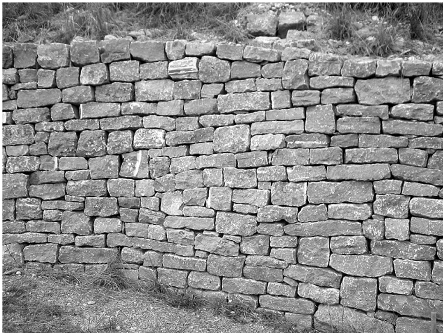
Abb. 1: Stützmauer als klassische Trockenmauer
