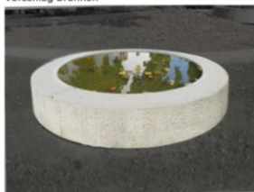
Beton eingefärbt, aussen sandgestrahlt / innen glatt
