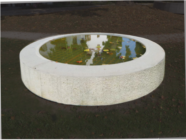
Beton eingefärbt, aussen sandgestrahlt / innen glatt
