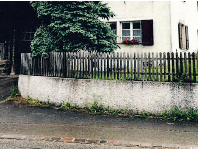
Referenzbild Mauer mit Holzzaun in Dorfgemeinde
