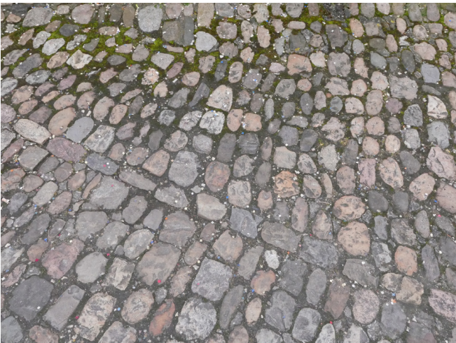
Milchhüüsli Pflasterung Rheinwacken
