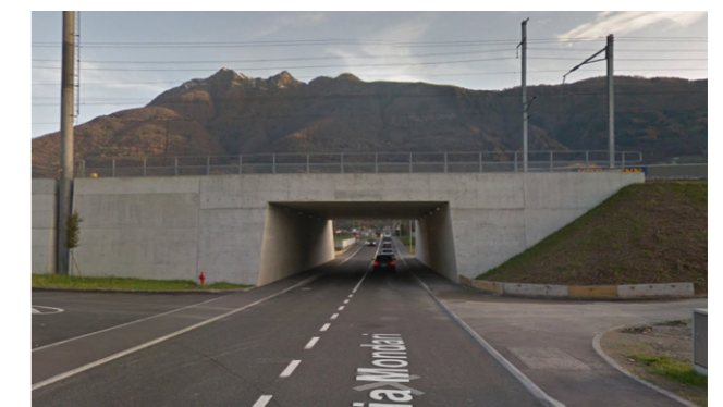
Beispiel Unterführung in einer Stützwand (ATG, Camorino)
