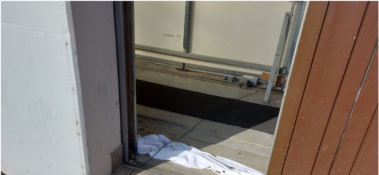
Abb. 2: Foto des Geofons G 7 auf dem Beton des Eisfeldes.
