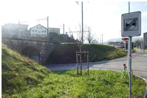
Abb. 3: Blick Richtung Südwesten zur Bahnunterführung hin, Flächen Nr. 6 und Nr. 2 Gartenareale / Beginn Bahnböschung und Nr. 7a ein Teil der Bahnböschung.
