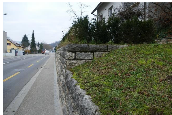
Abb. 40: Fläche 20: Blick Richtung Westen. Rechts im Bild ist das Gebäude an der Baslerstrasse 77 mit jungen Eiben als Sichtschutz zu erkennen.
