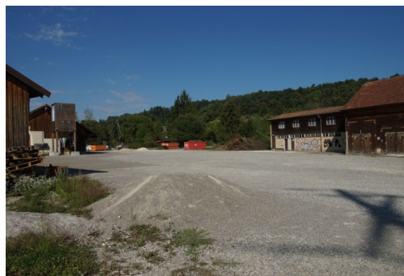
Abb. 18: Werkhofareal (Nr. 11), Blick Richtung Nordwesten.
