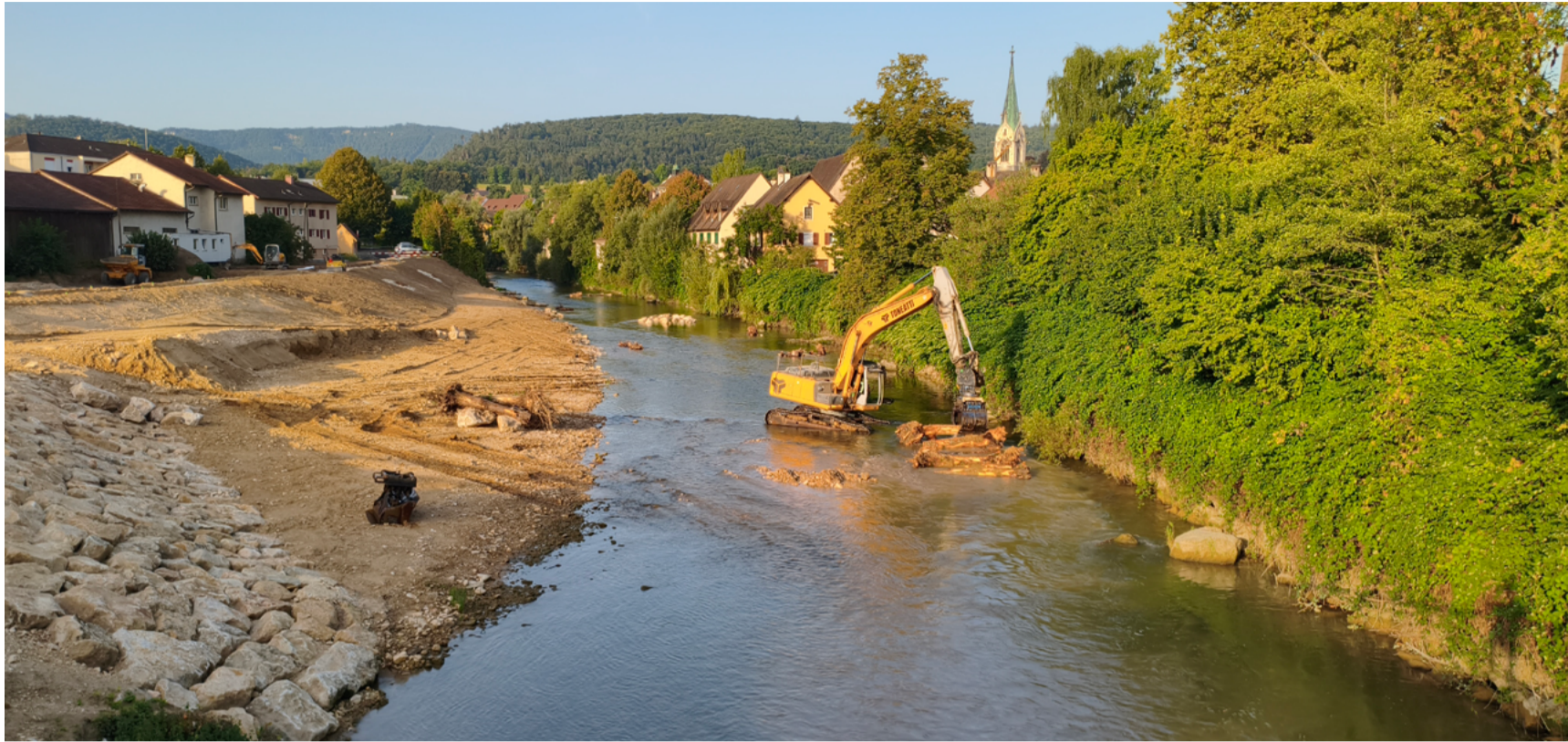
Nach der Aufweitung des Birsbetts beim Kulturzentrum Alts Schlachthaus wird der Abschnitt Nau-West bis im Frühling 2026 begrünt und mit Sitzsteinen ausgestattet. (Bild: Holinger AG)
