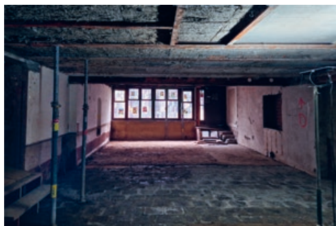
4.6 Der gegenüber dem Strassenraum abgesenkte Innenraum der Schützenstube während der Bauphase. Nur die alten Fensterscheiben erinnern an die einstige Nutzung des Restaurants.
