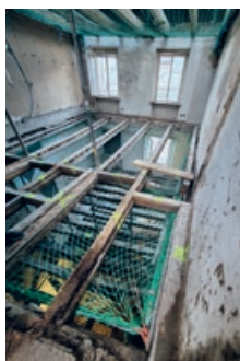
4.4 Die Deckenkonstruktionen wurden bei den «Hinterhäusern» an der Mühlegasse bis auf die Tragbalken zurückgebaut. Dies führte in der Bauphase zu eindrucksvollen Absturzsicherungen.
