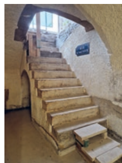
4.5 Die alte Steintreppe der Stedtlbar diente zuletzt «lediglich» als Sitzgelegenheit bei feuchtfröhlichen Anlässen. Dank der Deckenöffnung wird sie wieder ihrer ursprünglichen Funktion zugeführt.
