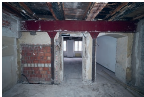
4.3 Bei den Rückbauarbeiten kam die Ingenieurlösung des Umbaus von 1969 zum Vorschein. Am grossen Eisenträger der seitlich auf den Brandwänden aufliegt, wurden vertikale Metallzugbänder montiert, welche die Deckenkonstruktion über dem Erdgeschoss abfangen.
