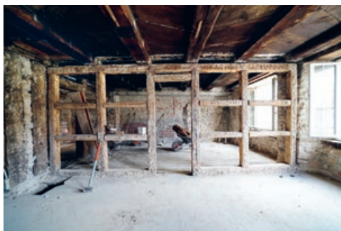
3.2 und 3.3 Historisches Tragwerk, Rheinfelderstrasse 2, Sissach
