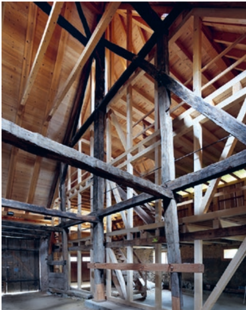
3.9 Hochfirst sichtbar im Gassenbrunnen 5+7, Ramlinsburg
