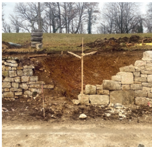
7.7 Unterschied alte und neue Mauer
