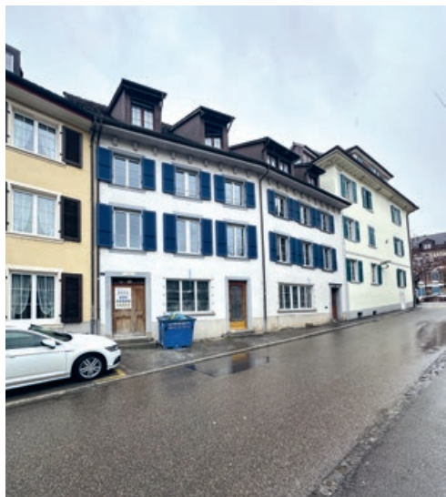
3.1 Strassenfassade Rheinfelderstrasse 2/4, Sissach
