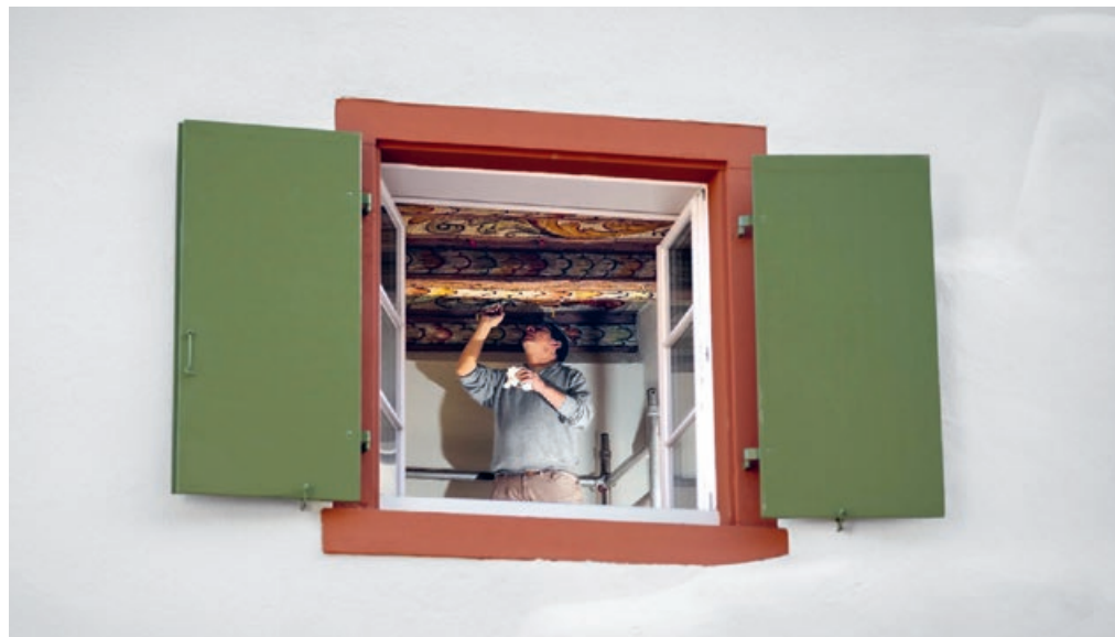
8.1 Arbeitsaufnahme Buess AG während der Restaurierungsmassnahmen
