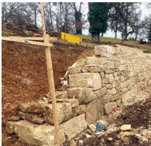
7.6 Aufbau Trockenmauer, 1. Fundamentstein, 2. Baustein, 3. Füllsteine, 4. Binder, 5. Deckstein
