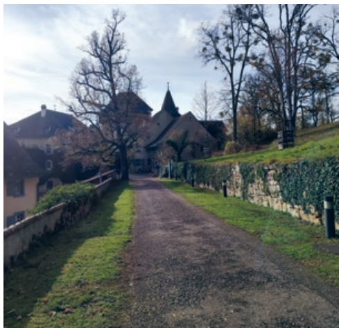
7.4 Zufahrt vor Sanierung 2024
