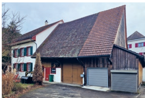
3.6 Frontfassade Alte Landstrasse 37, Tenniken
