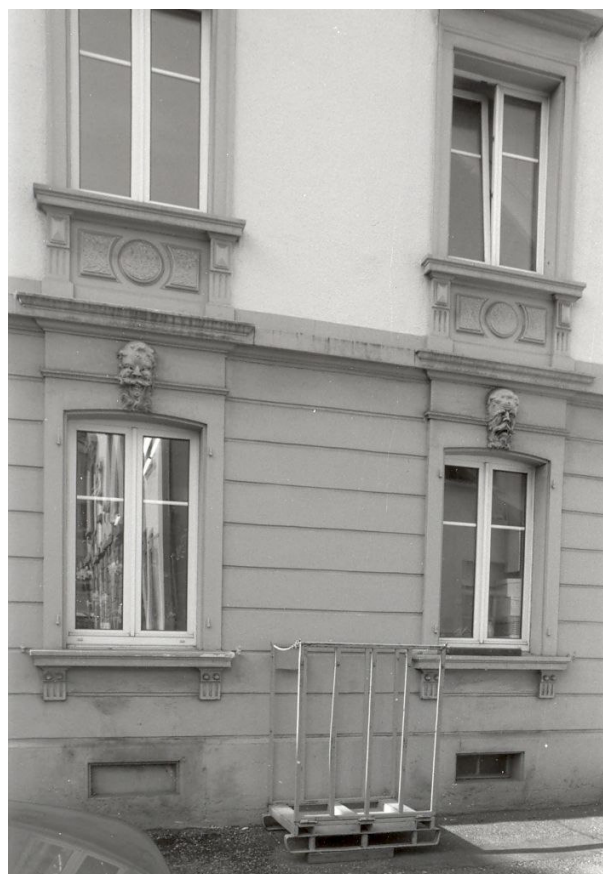
Fassade Nord, Bahnhofstrasse 33
