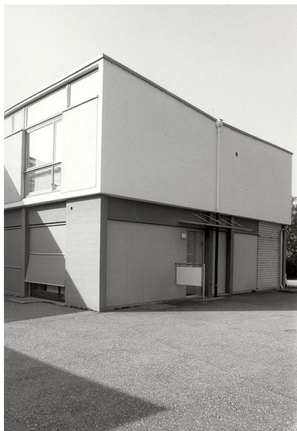
Produktionshalle, Ansicht Südost
