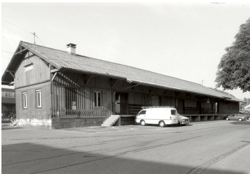
Güterschuppen, Ansicht Nordost
