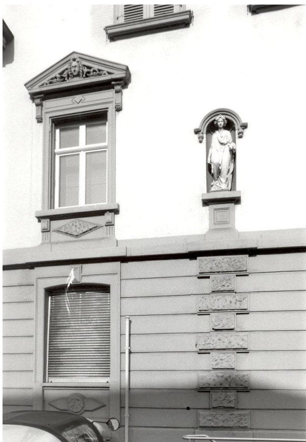
Fassade Ost, Hauptstrasse 31
