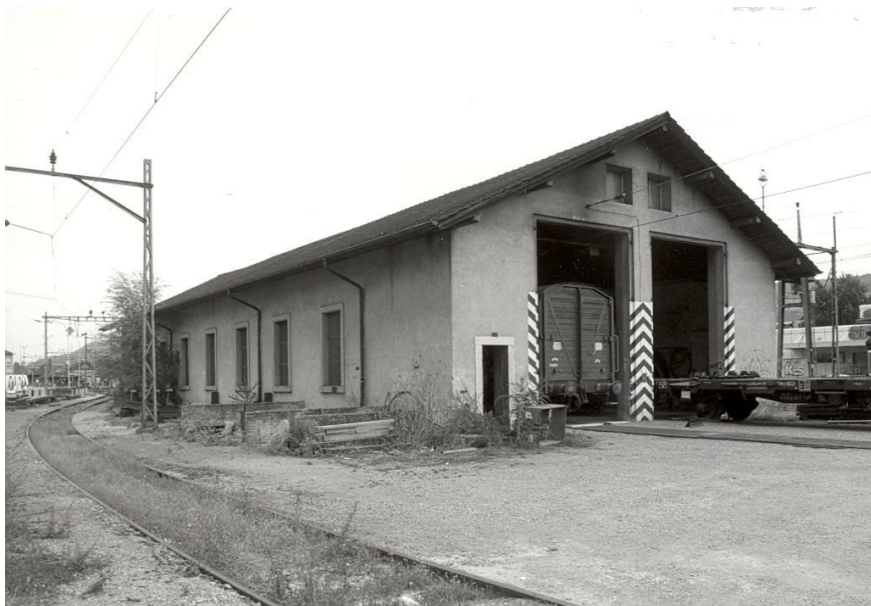
Lokremise, Ansicht Südost
