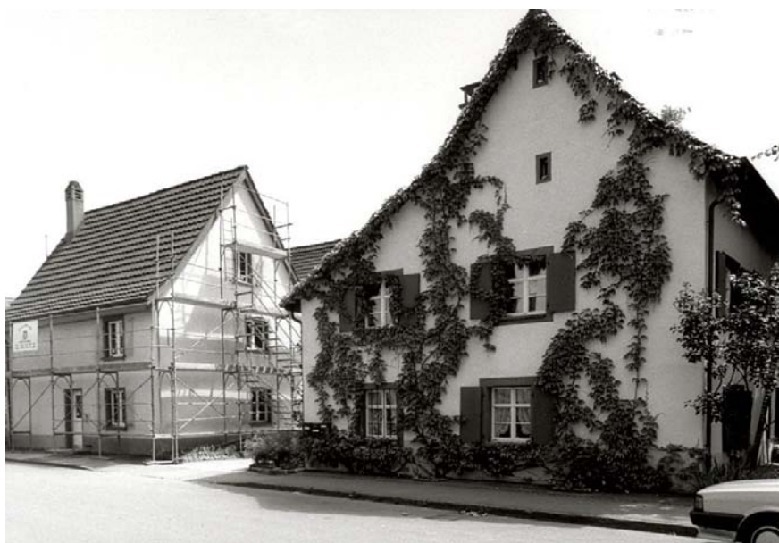
Ansicht Nord (Strassenseite)
