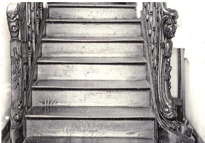
Treppe hinter Eingang West
