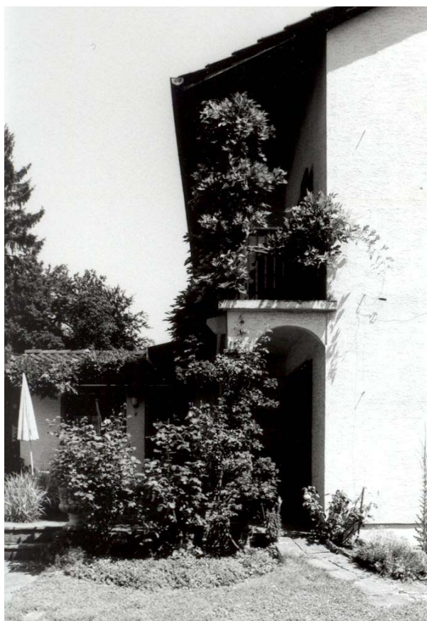
Detail Ecke Südwest
