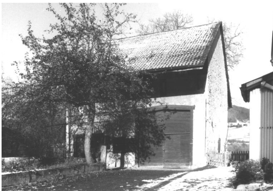
Scheune, Ansicht Südost
