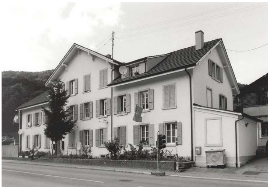
Fassade Süd, Nr. 22
