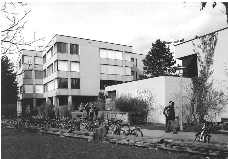
Schulhaus, Ansicht Ost
