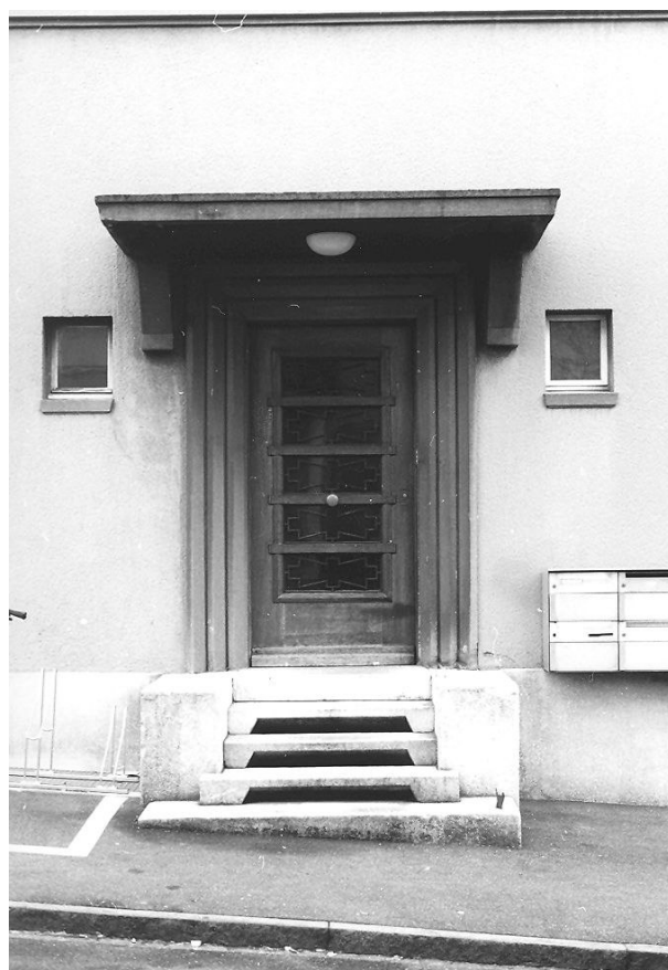
Eingang Nordwest (Wohnungen)
