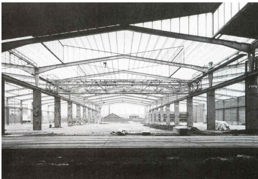
Halle im Montagezustand
