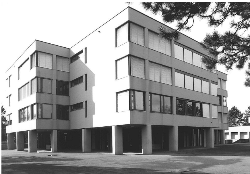
Schulhaus, Ansicht Nordost
