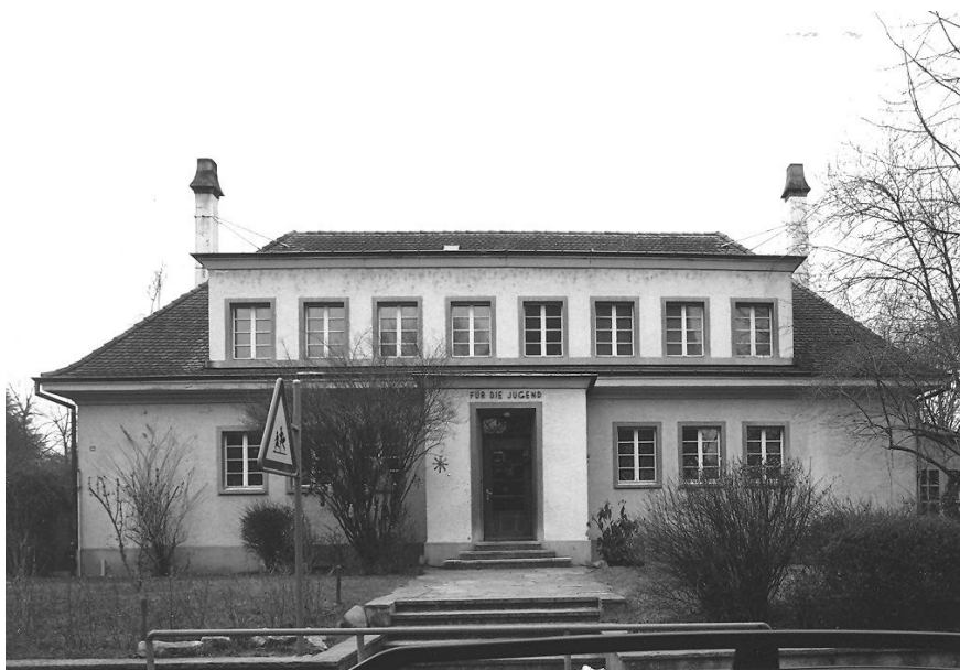
Ansicht Nordost (Schützenstrasse)
