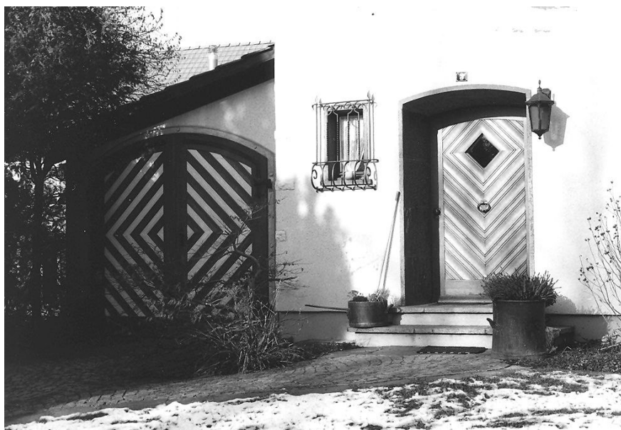
Details Garage, Eingang
