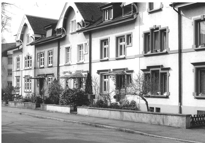
Ansicht Südost (Hofstrasse)
