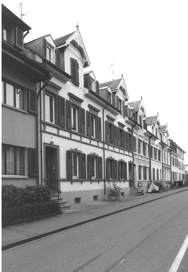
Ansicht Nordost (Schützenstrasse)
