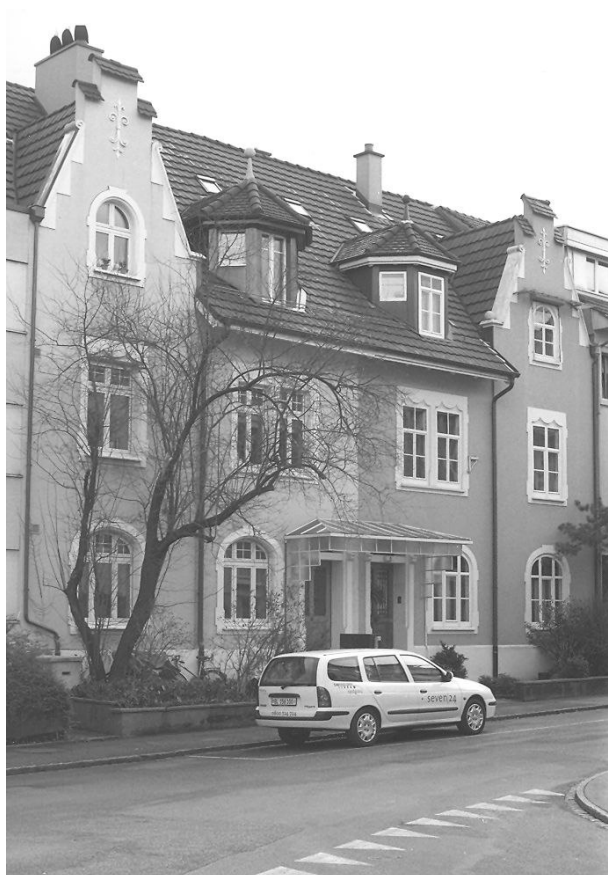
Ansicht Nordwest (Baslerstrasse)
