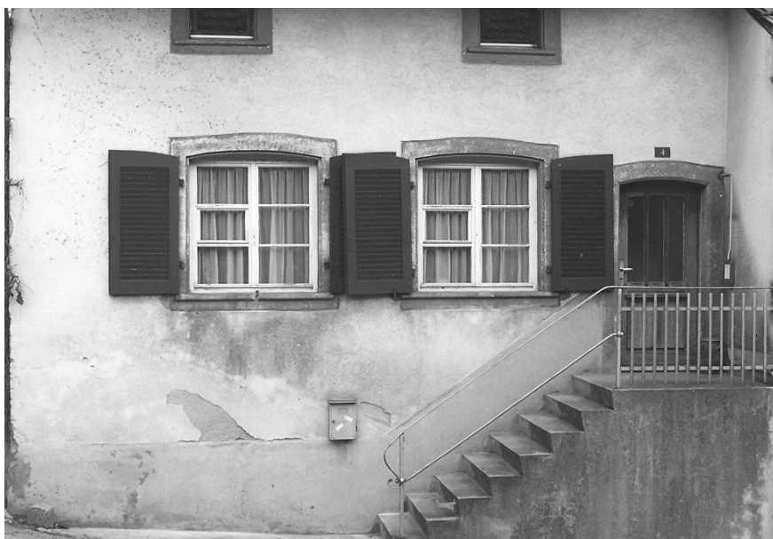
Detail Eingang Südwest
