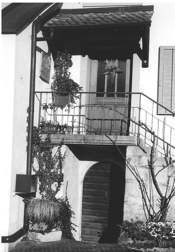
Detail Eingänge Südwest
