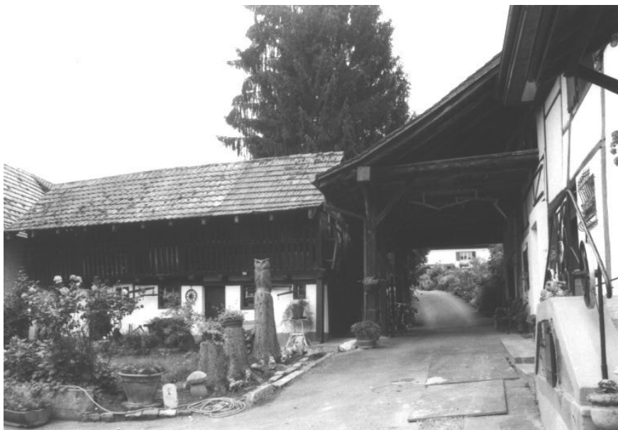
Schweinestall, Fassade Nordost
