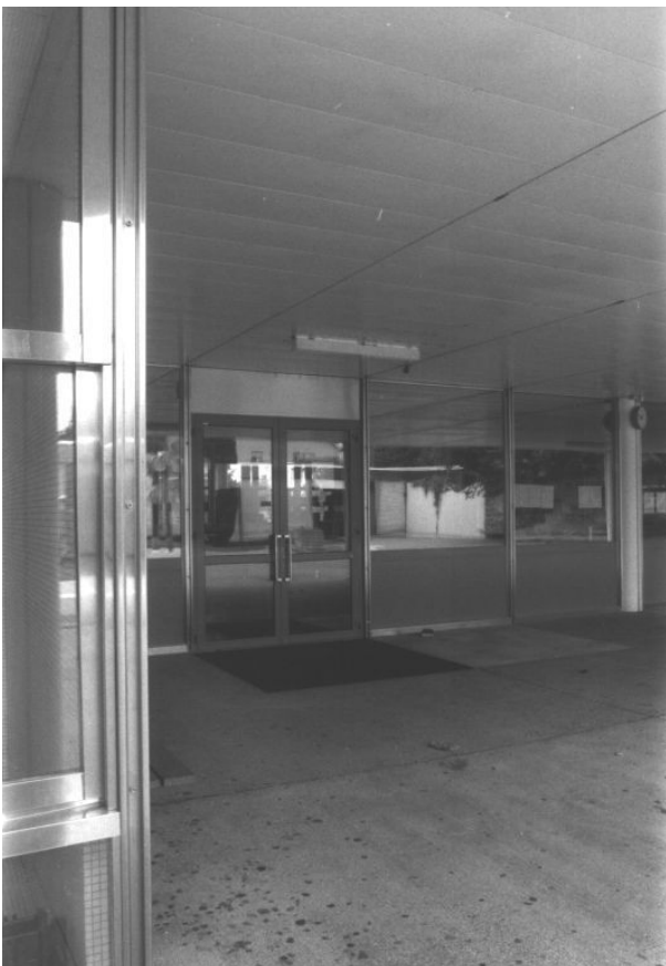
Eingang Südost, Klassentrakt
