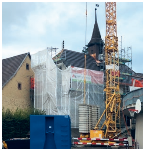
4.2 Hemmiken, Umbau des 1825 errichteten Schulhauses
