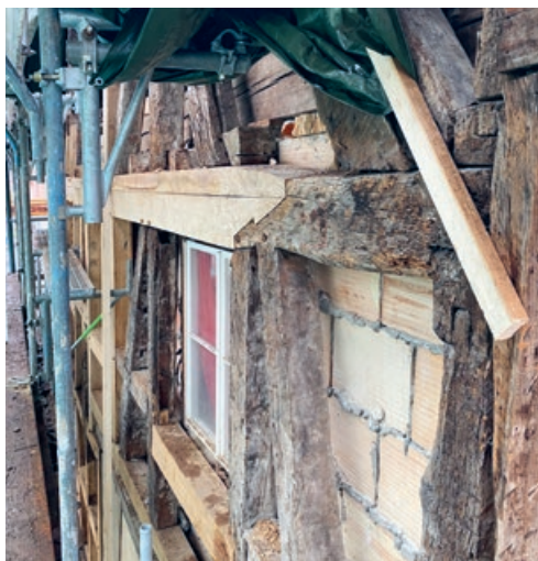
4.1 Allschwil, Gesamtanierung des um 1800 entstandenen Fachwerkes an der Oberwilerstrasse 5
