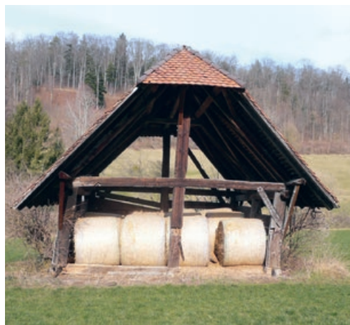
9.10 Südseite vor dem Abbruch 2021
