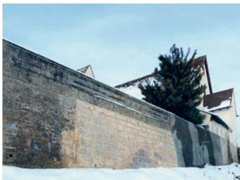
4.3 Ziefen, Sanierung der Stützmauer unterhalb der evangelisch-reformierten Kirche St. Blasius
