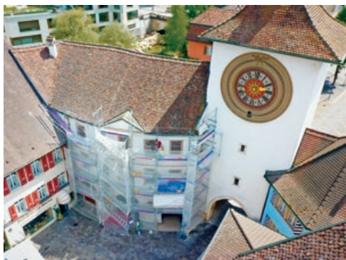
4.4 Laufen, Fassadensanierung des französisch-klassizistischen Rathauses
