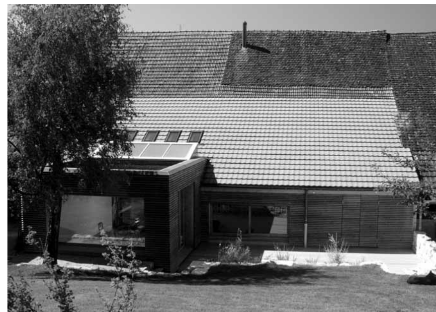
Abb.10: Oltingen, Haus im Baumgarten; vor Umbau Abb.11: nach Umbau
