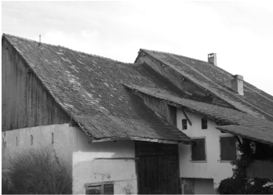
Abb.2, 3: Dachlandschaft mit und ohne Dachaufbauten
