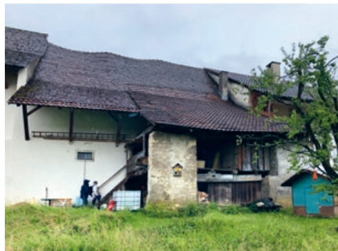
7.3 Die Hirschenscheune von Norden betrachtet. An der gewellten Firstlinie ist die Lage der Querbünde des liegenden Stuhls erkennbar. Der Dachstuhl wurde ohne Firsträhm konstruiert. Bedingt durch den fehlenden Kraftschluss der horizontalen Zugverbindungen am Dachfuss, haben sich die Sparren zwischen den Querbünden gesenkt und die Dachhaut entsprechend deformiert.
