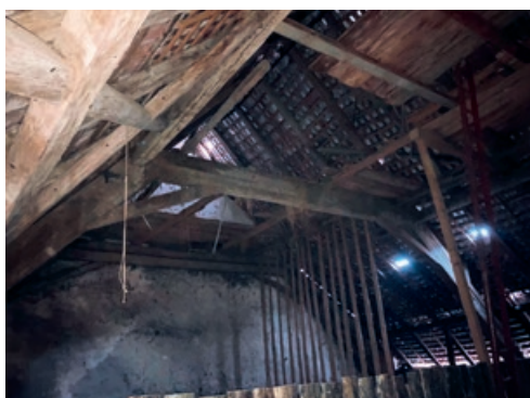
7.4 Blick in den Dachraum in Richtung Brandmauer zum ehemaligen Gasthof und Bauerngasse. Die Scheune besitzt ein beträchtliches Innenvolumen. Der Dachstuhl verfügt weder über ein Firsträhm noch eine Kehlbalkenlage.
