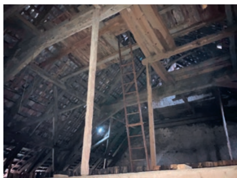
7.5 Blick Richtung Gartenfassade. Gut erkennbar die Stuhlkonstruktion, bestehend aus den trapezförmigen Querbündeln und den firstparallel verlaufenden Längsbündeln, den sogenannten Stuhlwänden, mit den markanten Andreaskreuzen, die den Dachstuhl in Längsrichtung stabilisieren.
