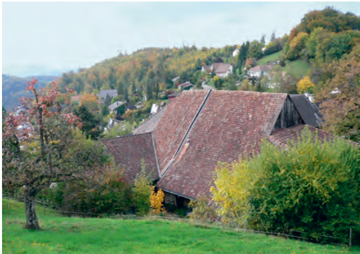
1 Ein Dach in Ramllinsburg birgt vertiefte Einsicht in die Zimmermannstechnik des 16. Jahrhunderts (lesen Sie S. 16)
