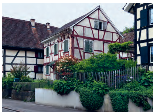
7 Allschwil, Schönenbuchstrasse 11 – Präzedenzfall einer Schutzentlassung
