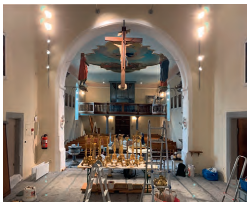
3 Die Renovation der Dorfkirche Allschwil wurde von Swisslos und durch den Bund subventioniert.
