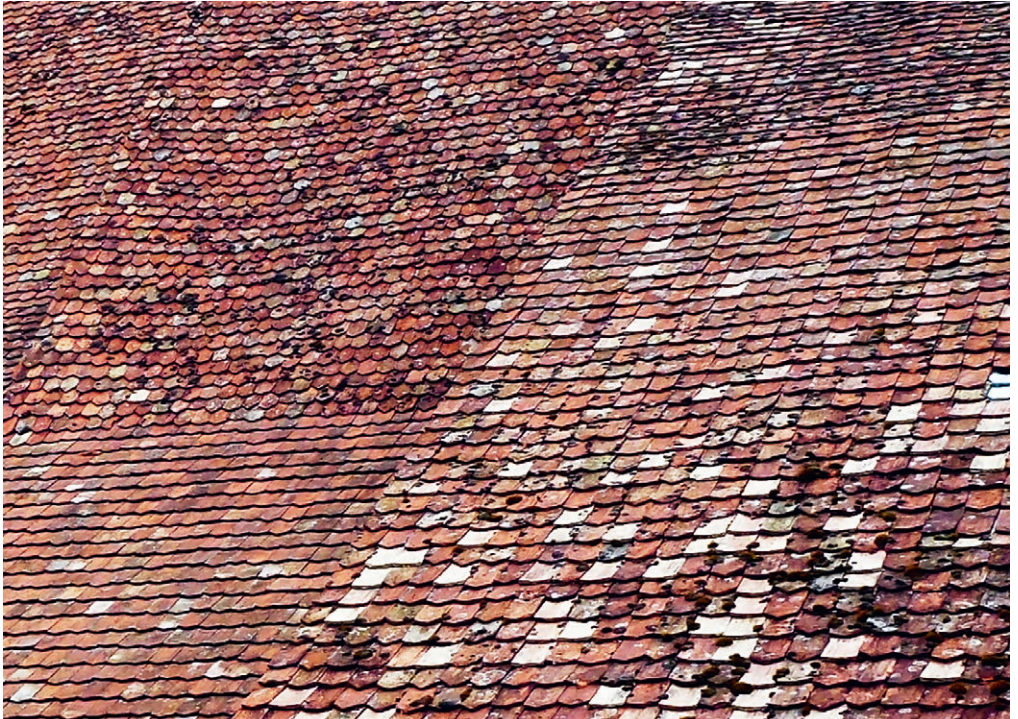
7 Dach mit Biberschwanzziegeln (Bild: Oltingen)
