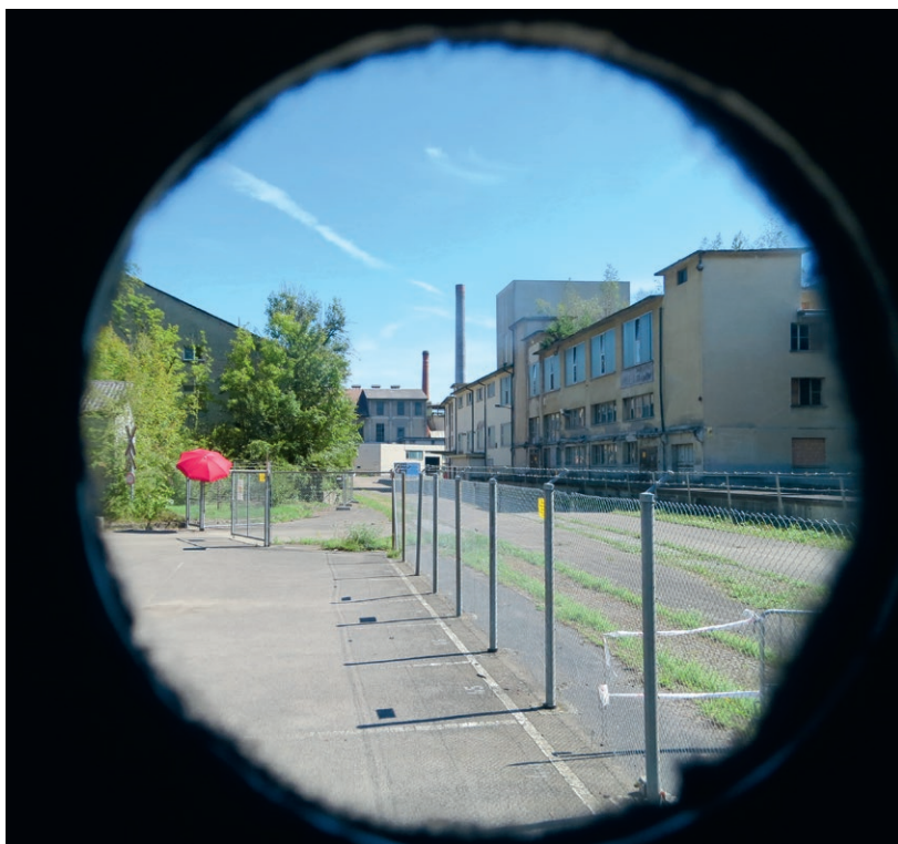
6 Die «Papiri» von Zwingen nach der Schliessung, vor dem Rückbau.
