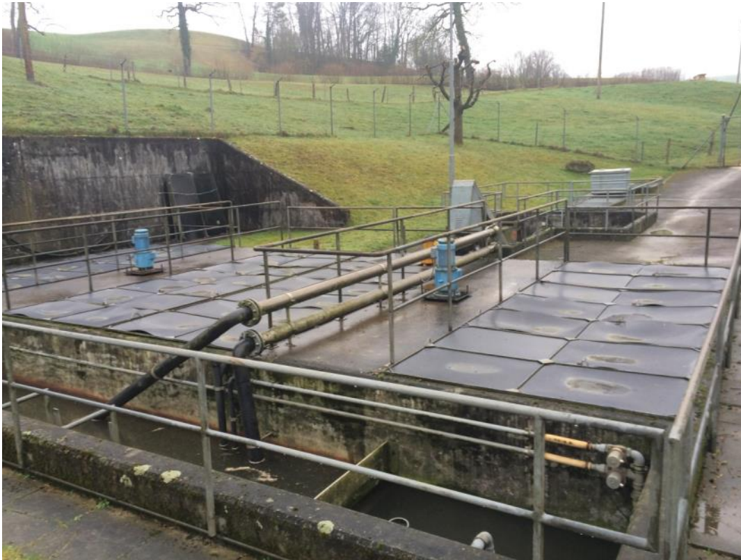
Abbildung 5: ARA Kilchberg/Zeglingen, Belebungs- und Nachklärbecken. Baujahr 1973.
