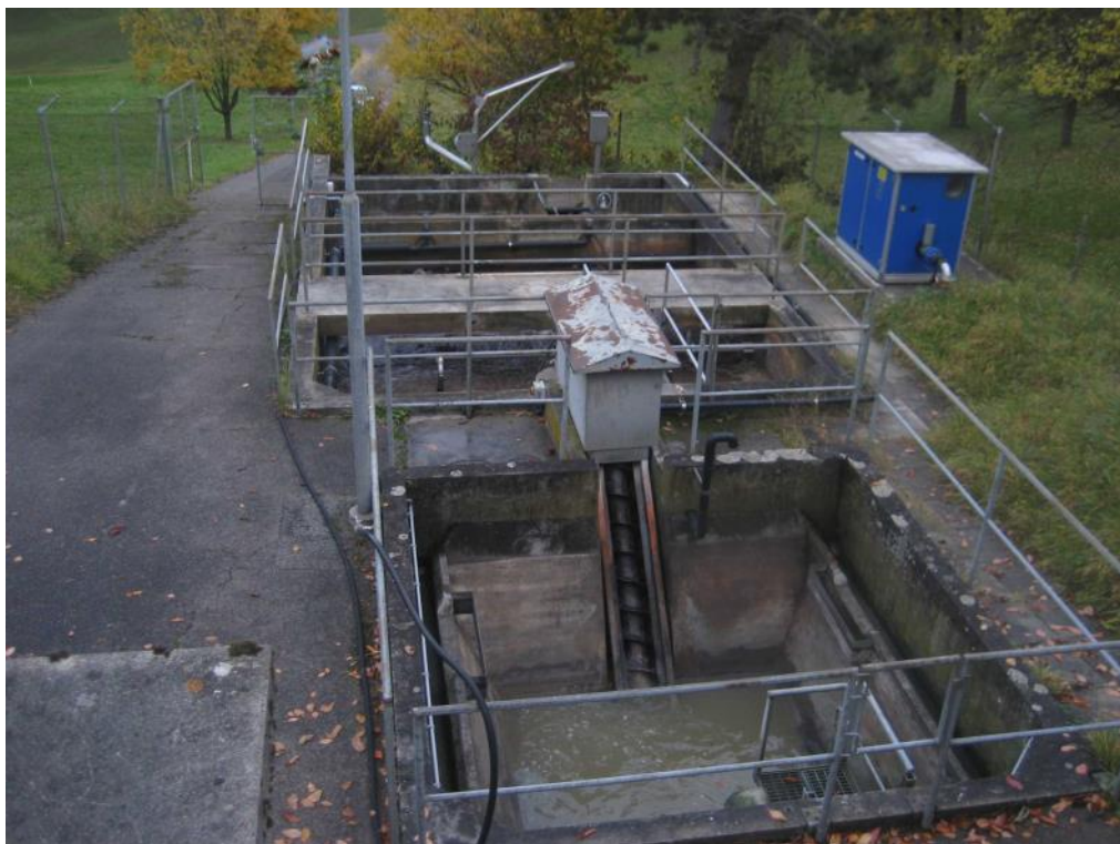
Abbildung 1: ARA Nusschhof, Hebewerk mit Belebungs- und Nachklärbecken. Baujahr 1968.
