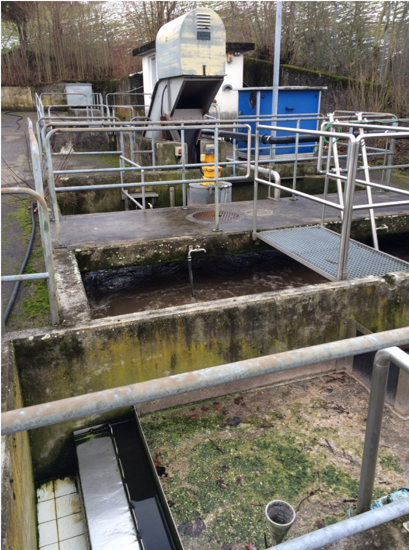
Abbildung 4: ARA Rünenberg Süd, Regen- und Belebungsbecken mit Nachklärbecken. Baujahr 1979.
