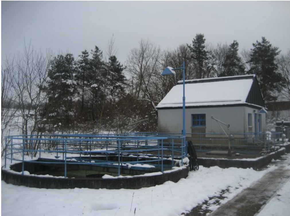
Abbildung 3: ARA Rünenberg Nord. Baujahr 1978, Nachklär- und Belebungsbecken, mit Betriebsgebäude, Mischwasserbecken. Baujahr 1993.
