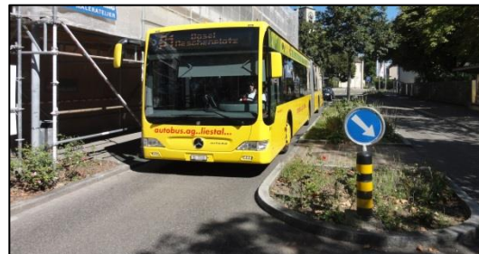
heutige Haltestelle Kirchmatt als Fahrbahnhaltestelle mit Querungshilfe für Fussgänger
