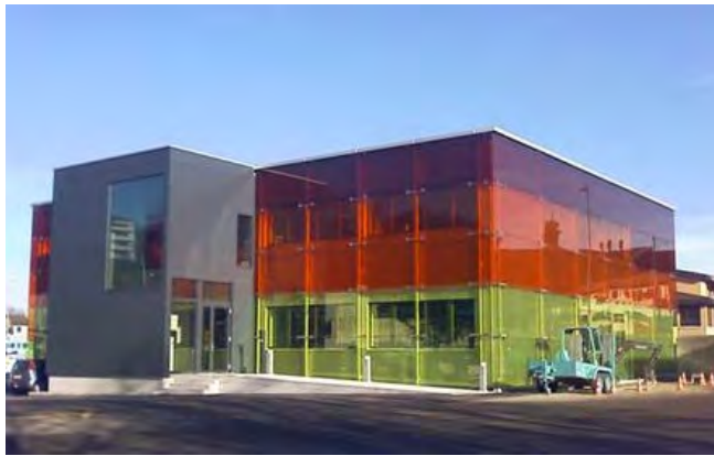
Abb.5: Das VMZ-Gebäude in Emmenbrücke (Quelle: ASTRA)
