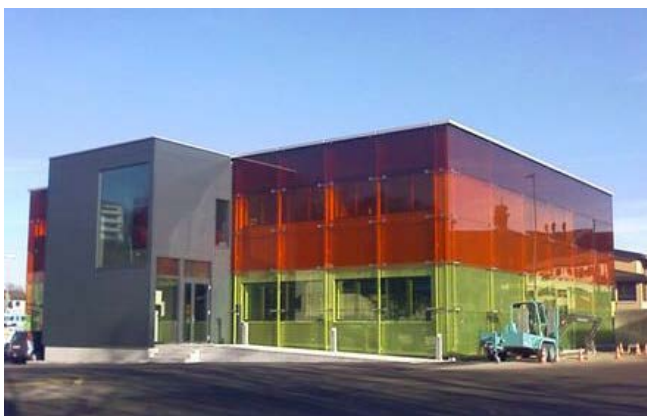
Abb.5: Das VMZ-Gebäude in Emmenbrücke (Quelle: ASTRA)
