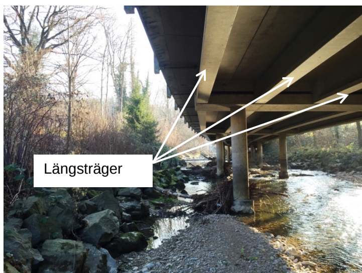
Abb. 04: Situation vor Ort
